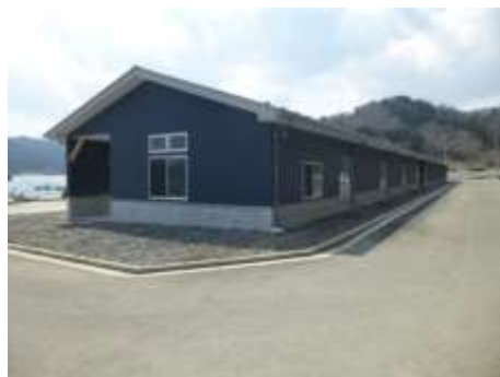
共同倉庫兼作業場 全景
