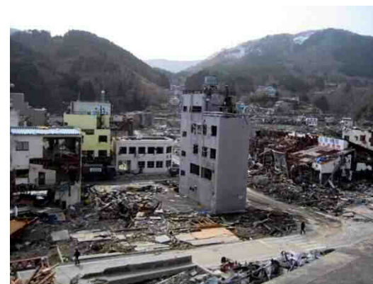
<当組合管内の被災状況>
